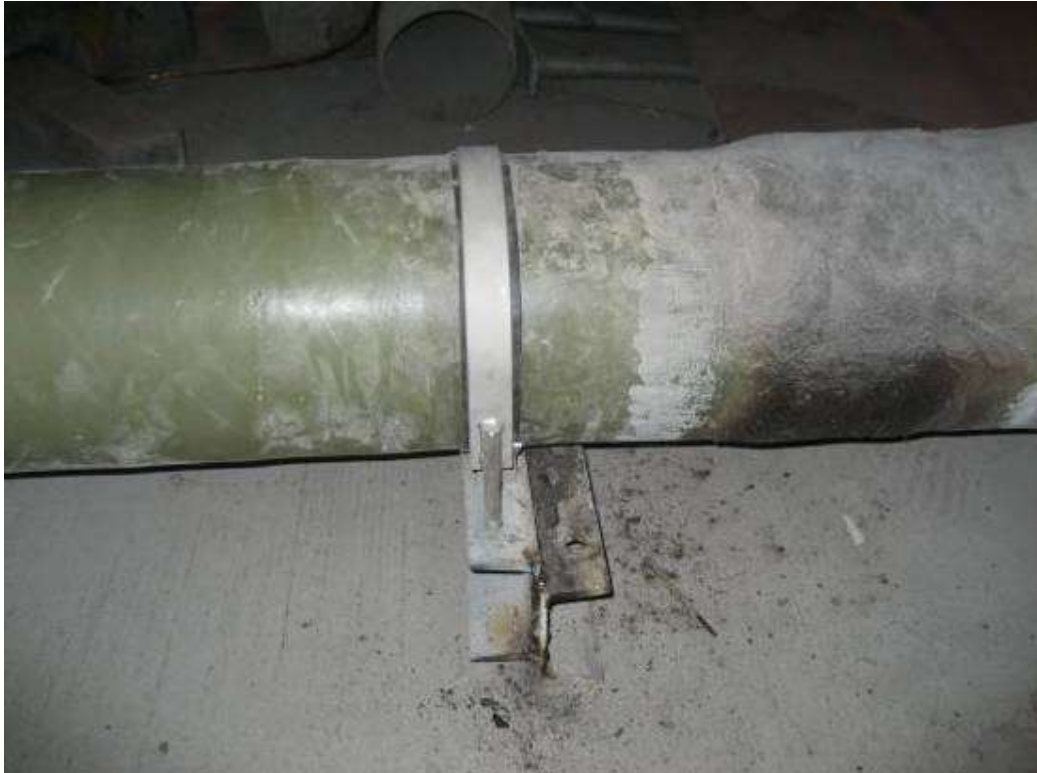
2008年7月20日 ECB Piping&Support 現場施作紀錄相片
