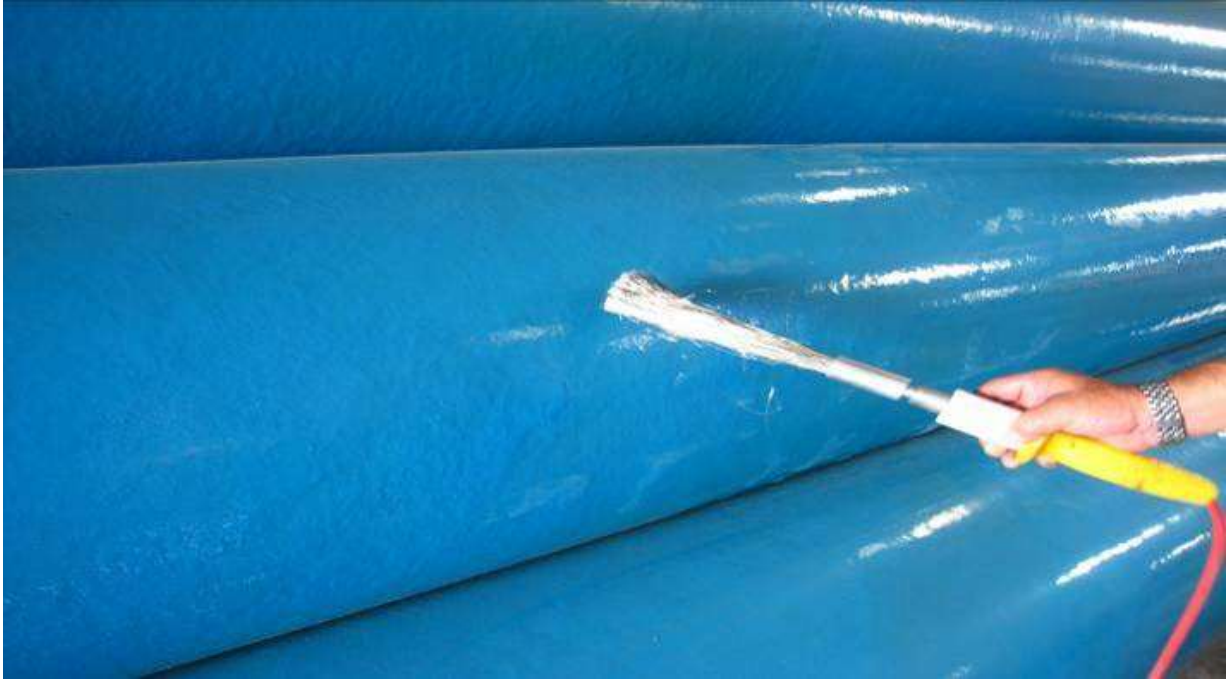
施工中 103.6.16 24" 管 PE 包覆 12000V 針孔測試
