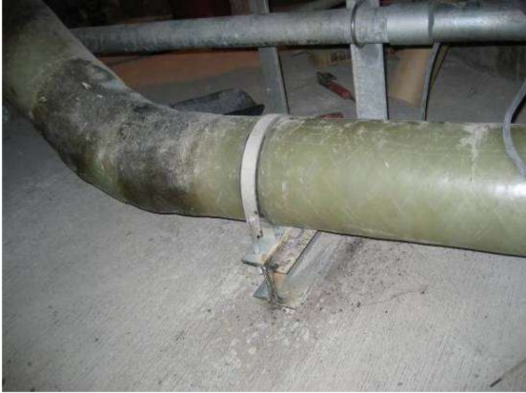
2008年7月20日 ECB Piping&Support 現場施作紀錄相片
