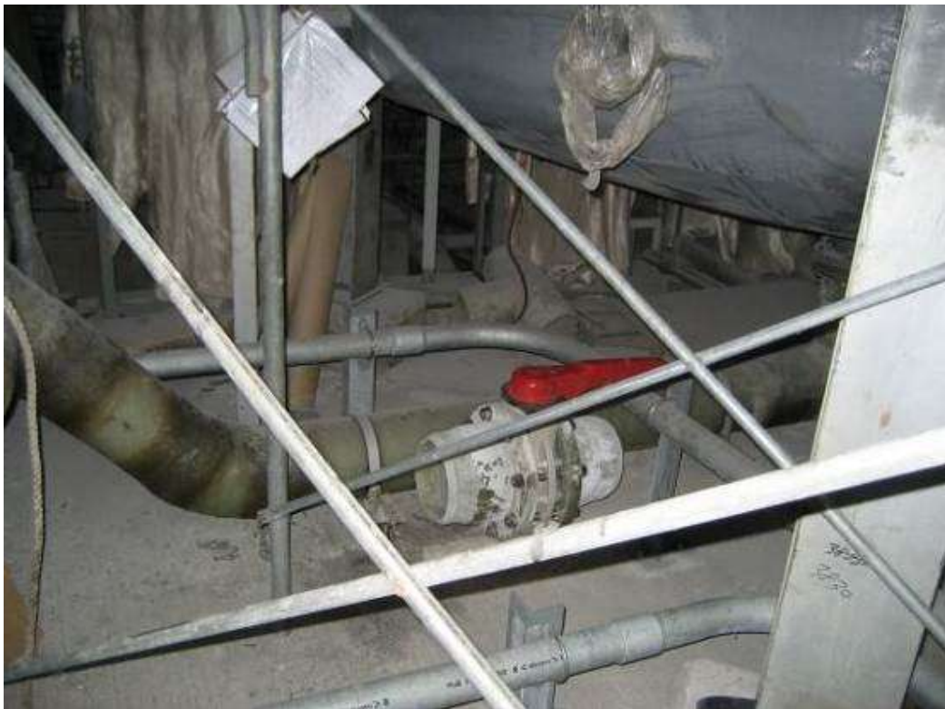
2008年8月14日 ECB Y54 系統Piping 紀錄相片
