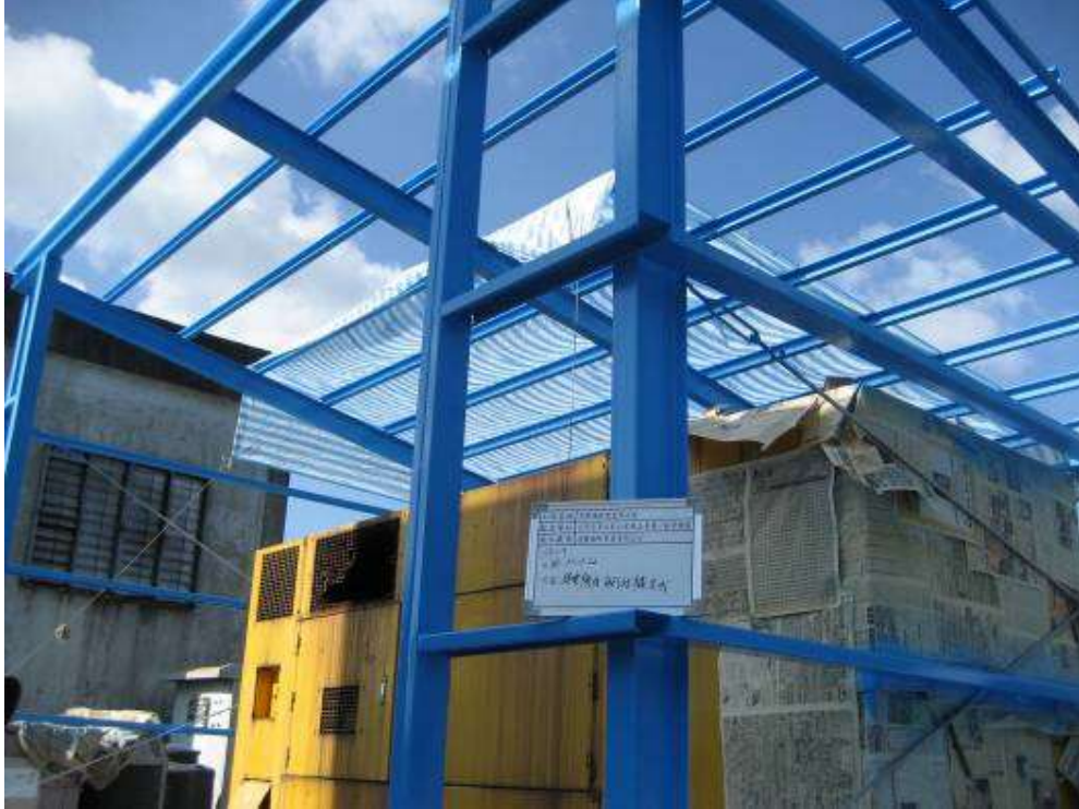
2009年9月22日, 下午 02:51 貢寮、雙溪營運所(鋼骨結構完成)(施工中紀錄片)
