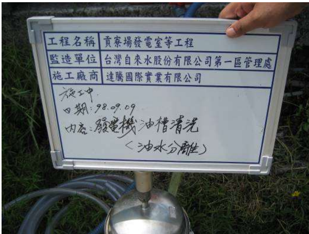
2009/09/09 上午 11:21 貢寮、雙溪營運所(發電機油槽清洗)(施工中紀錄片)
