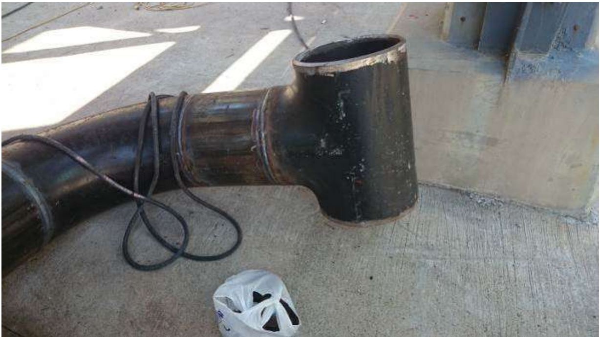
103.8.16 施工中-TIE IN 管預製
