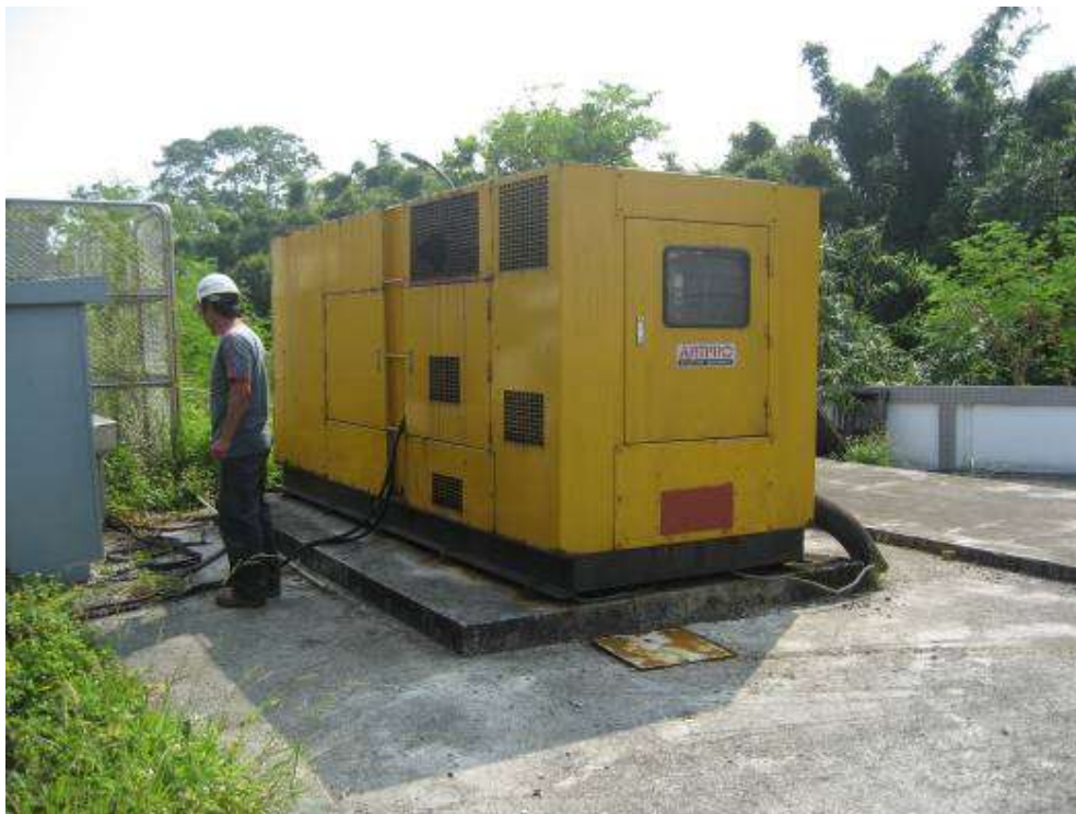
2009/09/01 上午 09:24 貢寮、雙溪營運所(施工前紀錄片)
