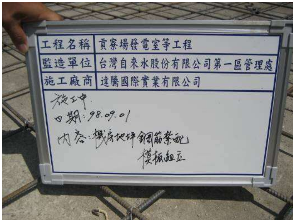
2009/09/01 上午 10:43 貢寮、雙溪營運所(發電機室地坪鋼筋紮配、模板組立)(施工中紀錄片)
