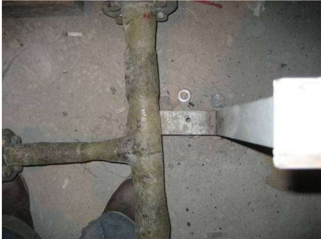
2008年7月20日 ECB 現場施作紀錄相片
