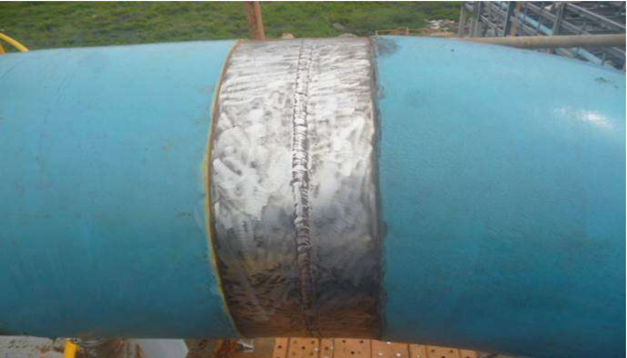
103.8.16 施工中-接合點PE防蝕纏繞包覆除銹
