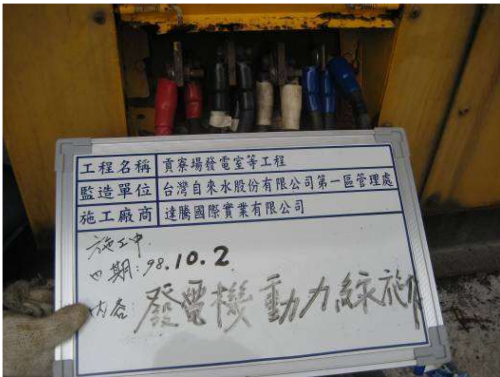
2009年10月2日, 下午 02:23 貢寮、雙溪營運所(發電機動力線施作)(施工中紀錄片)
