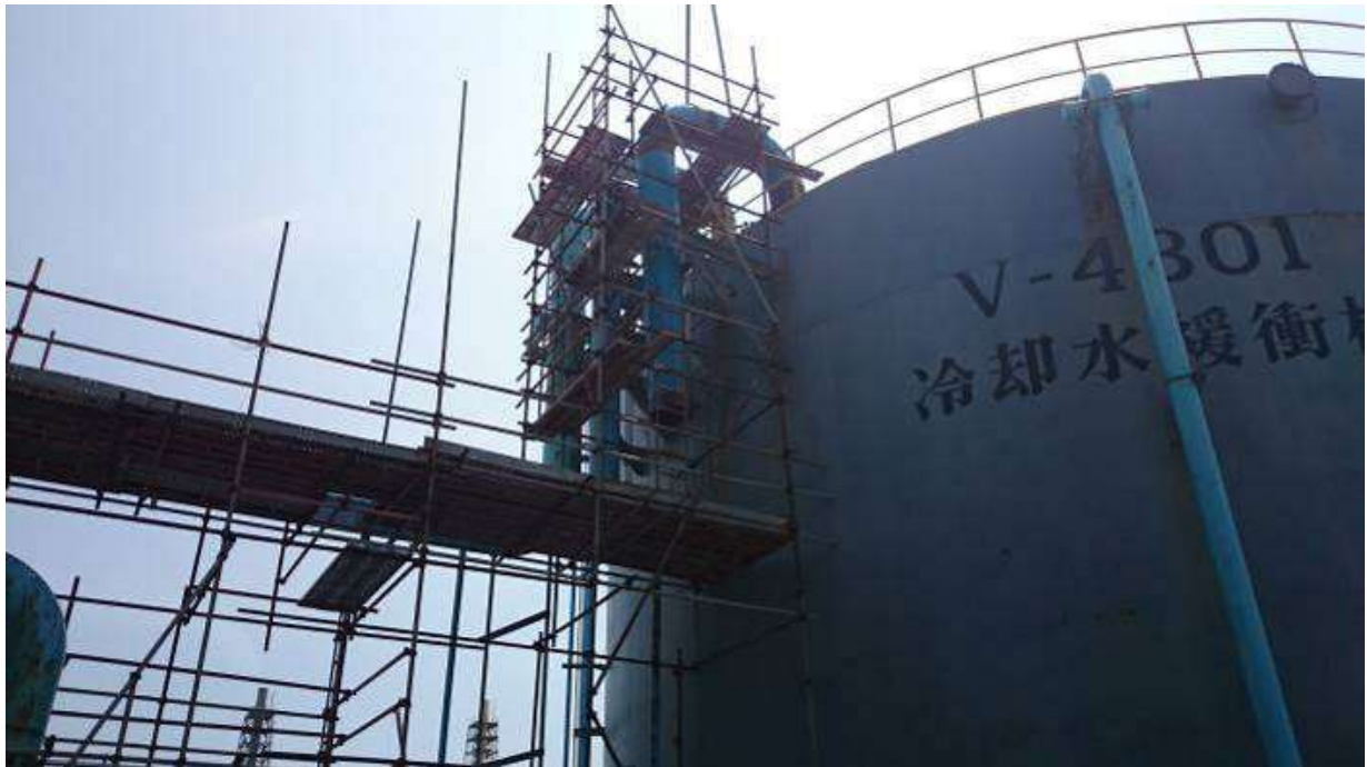
103.7.28 施工中- 24" 冷却水迴流管線(24" -CWR-0008-AA2)配管
