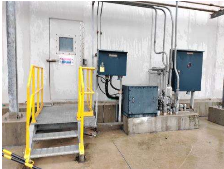
台電大潭發電廠#7機支援 GE 公司汽渦機儀控安裝工程
