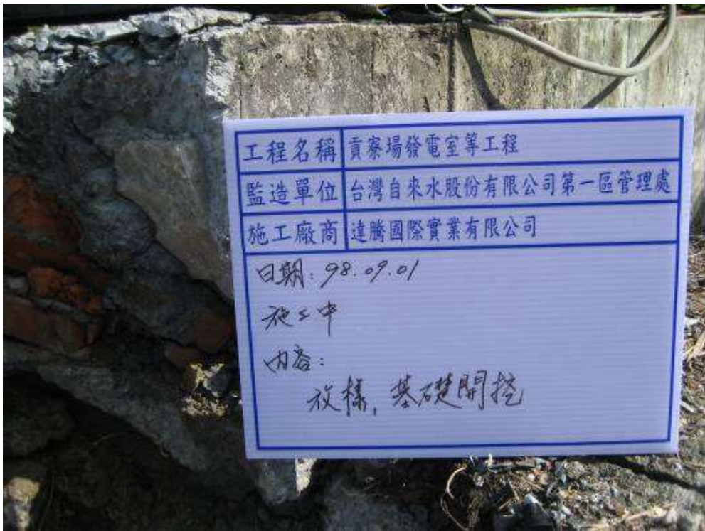
2009/09/01 上午 09:35 貢寮、雙溪營運所(放樣、基礎開挖)(施工中紀錄片)
