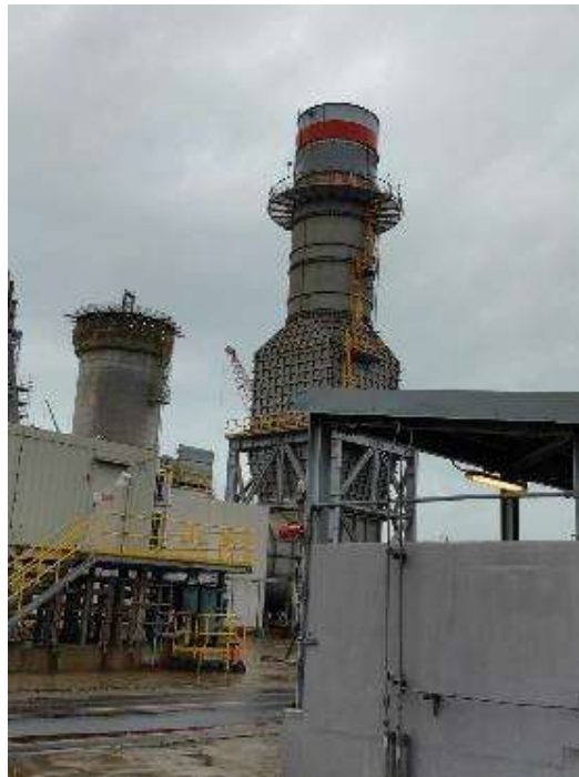
台電大潭發電廠#7機支援 GE 公司汽渦機儀控安裝工程
