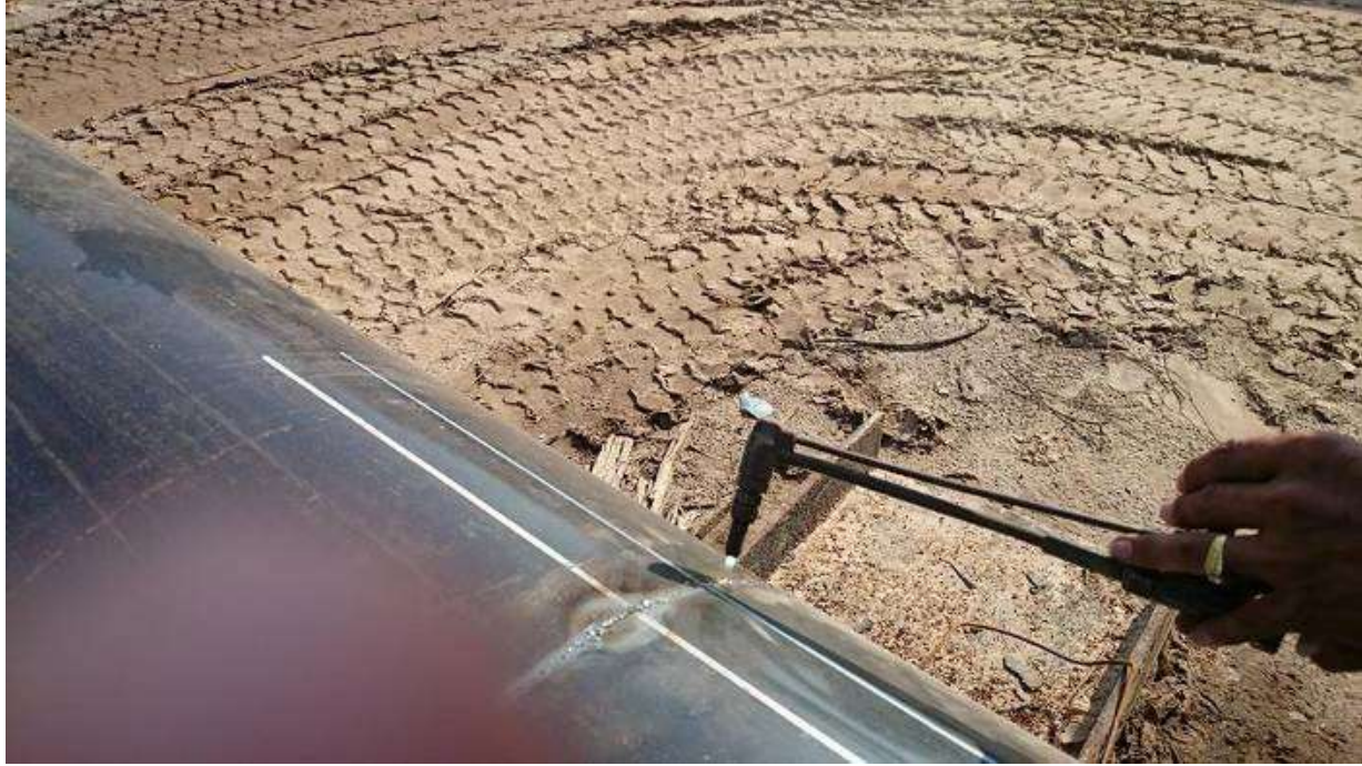
取樣中 103.5.27 批號 SIN2211030 24" A53 B PIPE
