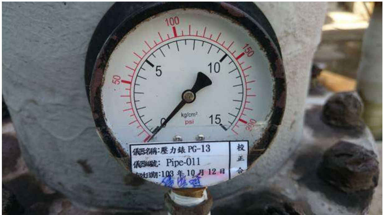
103. 8. 16 施工中-管線持壓\壓力表(有效期限103. 10. 12)\持壓前表歸零
