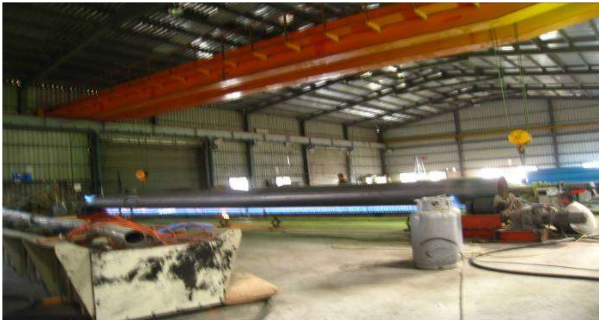
施工中 103.6.14 -24" 管 PE 包覆
