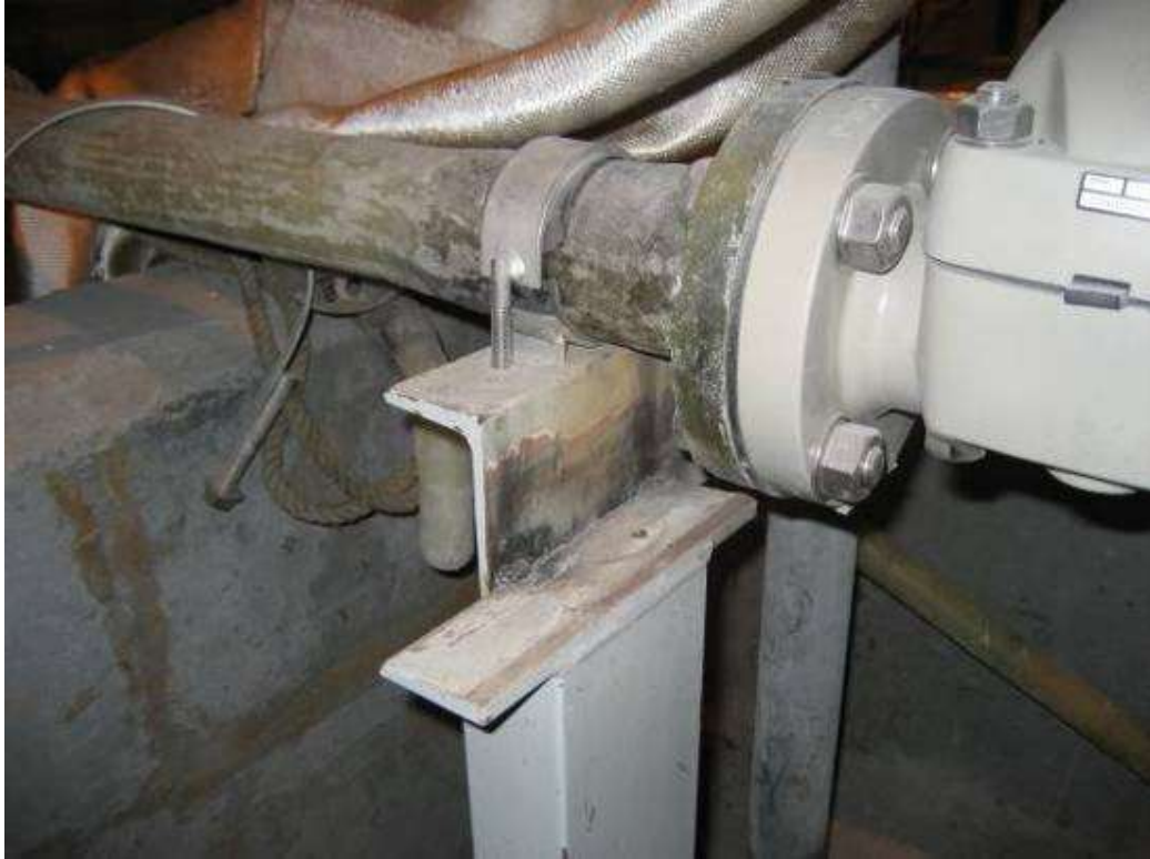
2008年7月20日 ECB 現場施作紀錄相片
