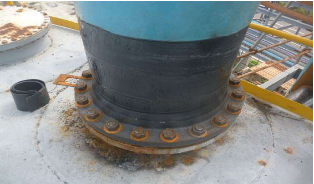
103.8.16 施工後-接合點 PE 防蝕纏繞包覆
