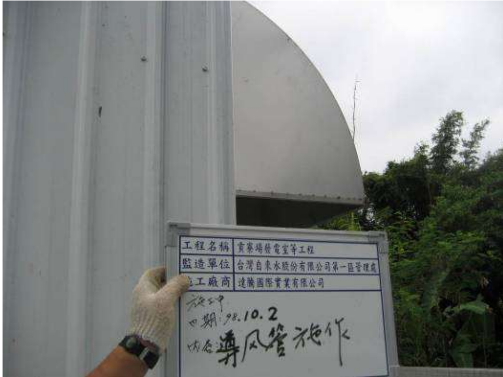
2009年10月2日, 下午 02:23 貢寮、雙溪營運所(發電機房導風管施作)(施工中紀錄片)
