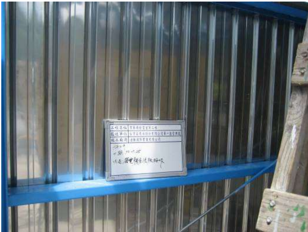
2009年9月25日, 下午 12:13 貢寮、雙溪營運所(發電機房浪板鋪設)(施工中紀錄片)
