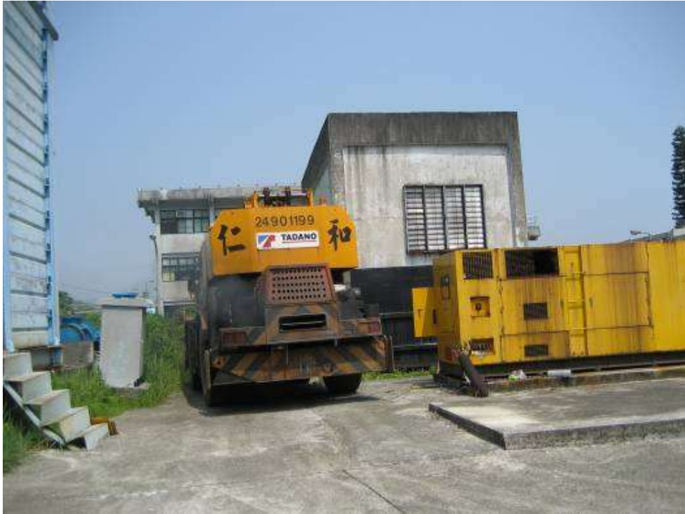
2009/09/01 上午 09:35 貢寮、雙溪營運所(拆除發電機暫時遷移)(施工中紀錄片)
