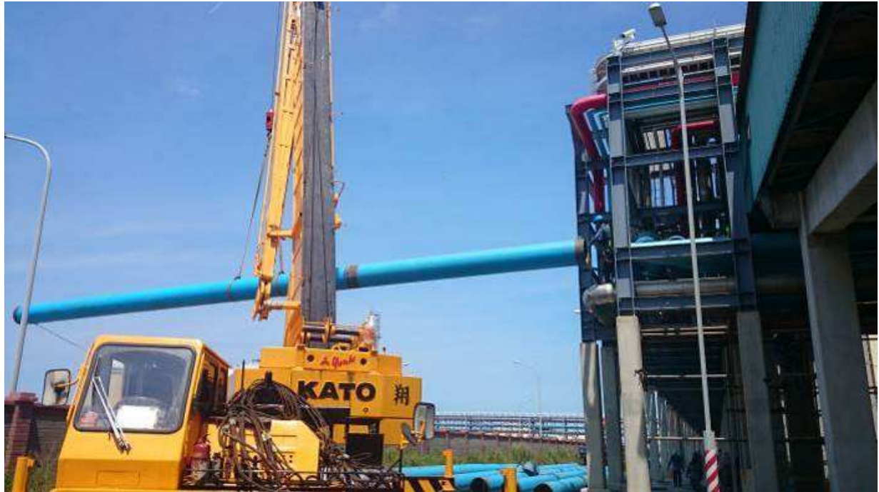
103.7.19 施工中-600A PIPE STD 9.5t 141kg/M BWE 30噸全吊車吊裝
