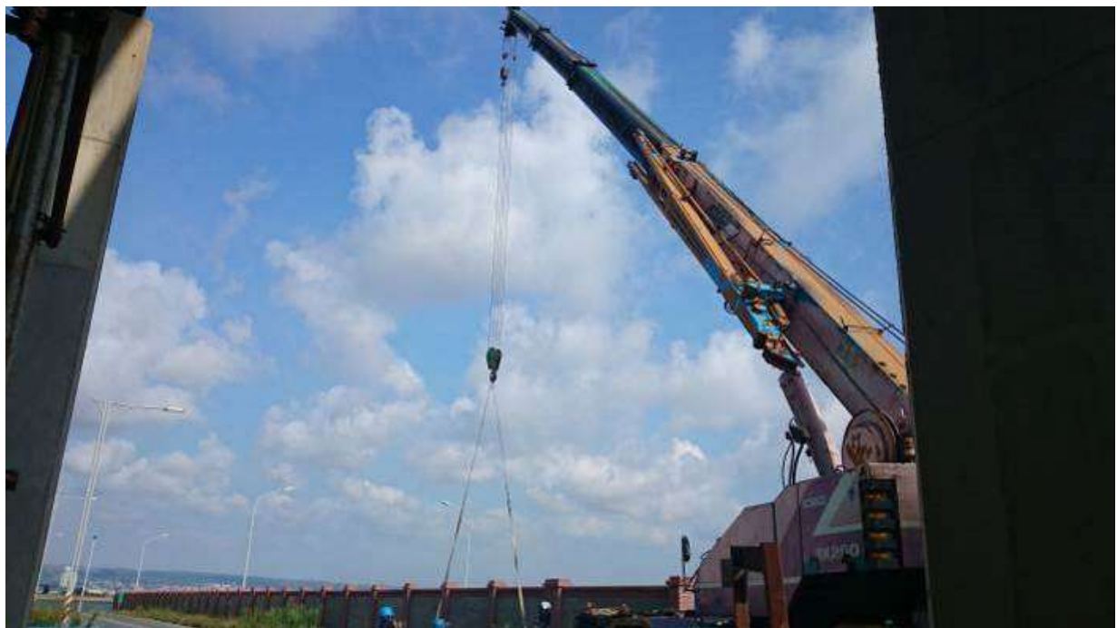
103.7.18 施工中-600A PIPE STD 9.5t 141kg/M BWE 吊裝
