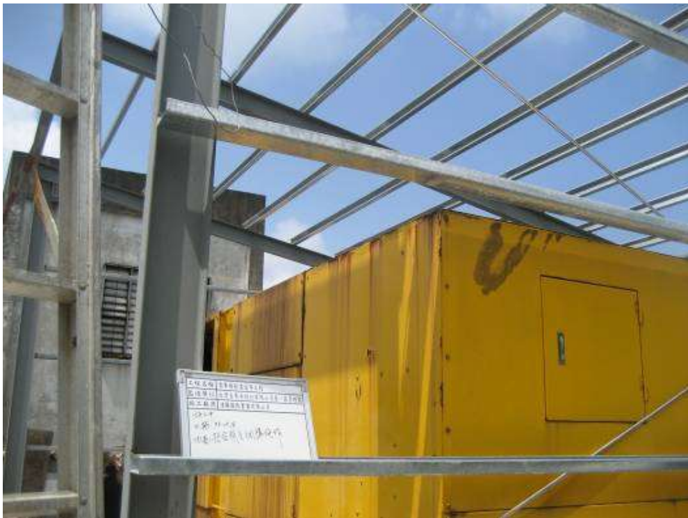
2009/09/16 下午 12:44 貢寮、雙溪營運所(鋼構機房施作)(施工中紀錄片)
