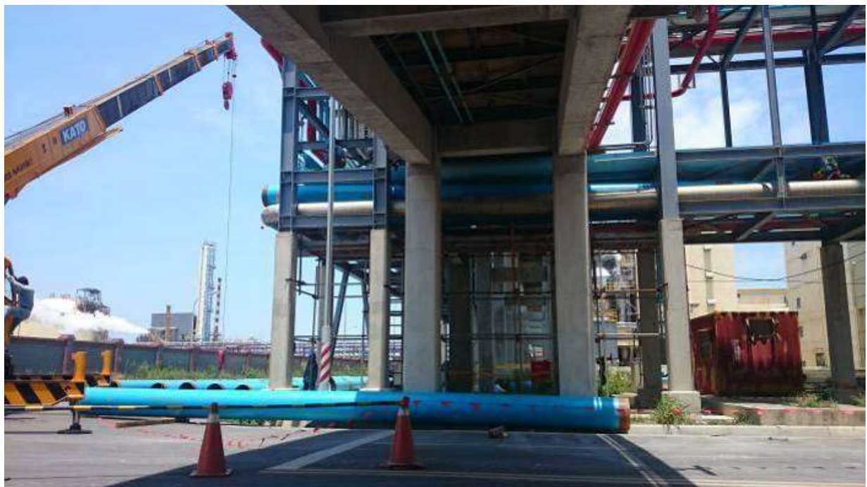
103.7.19 施工中-600A PIPE STD 9.5t 141kg/M BWE 吊裝(滾輪輔助推進)
