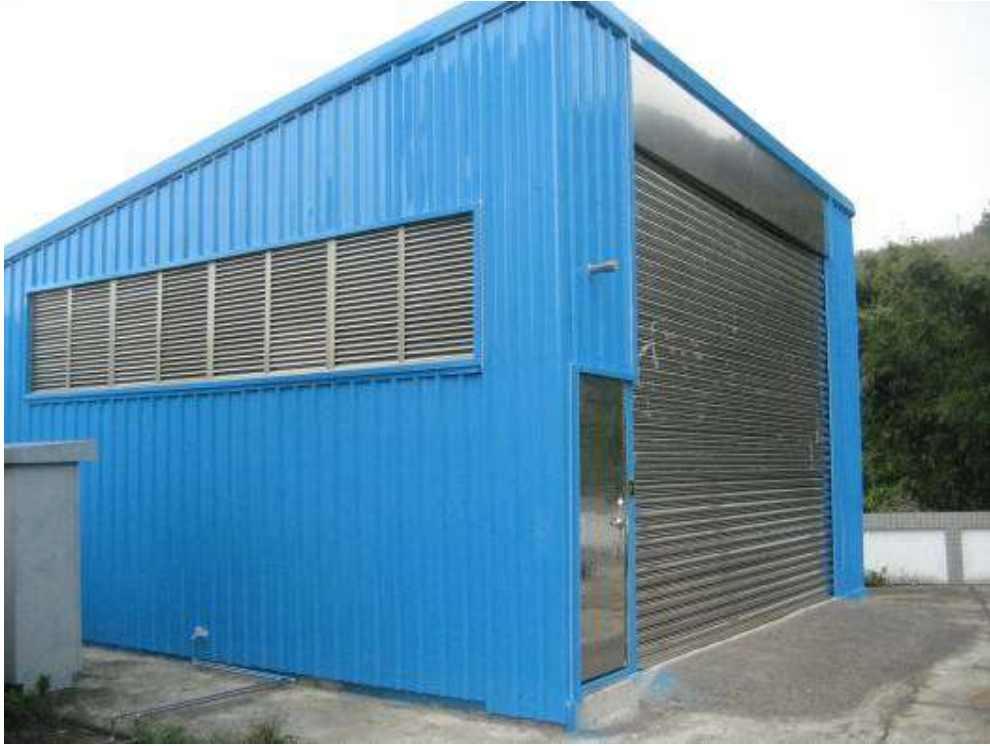
2009年10月20日, 下午 04:21 貢寮、雙溪營運所(發電機房完成)(施工後紀錄片)
