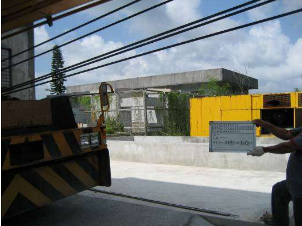
2009/09/11 下午 02:20 貢寮、雙溪營運所(發電機及油槽安裝定位)(施工中紀錄片)
