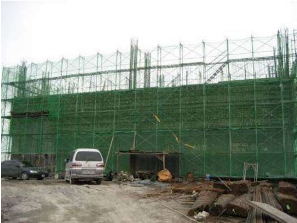
2007年2月14日 ECB主結構外觀現況相片
