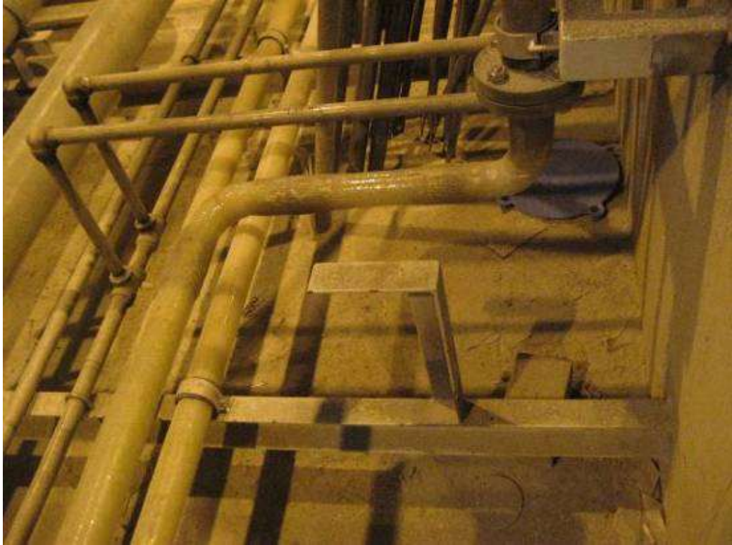
2008年7月18日 ECB Piping 現場施作紀錄相片
