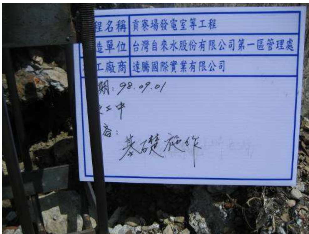
2009/09/01 上午 10:25 貢寮、雙溪營運所(發電機室基礎施作)(施工中紀錄片)
