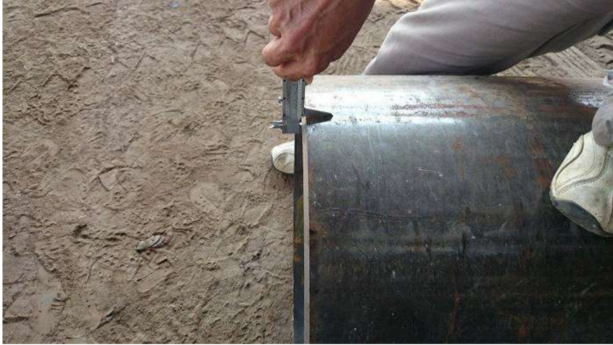
施工前 103.5.27 24" A53 B PIPE 厚度自主檢查
