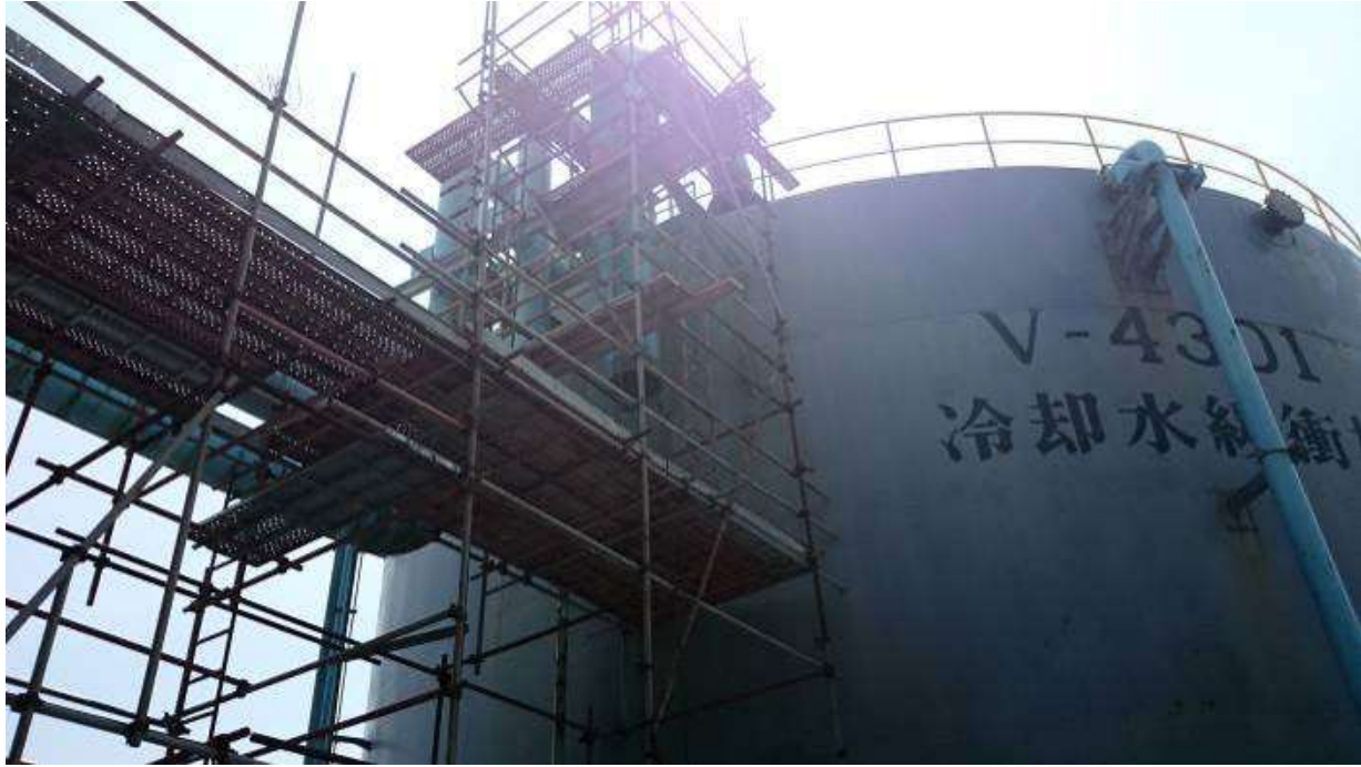
103.7.28 施工中- 24" 冷却水迴流管線(24" -CWR-0008-AA2)配管
