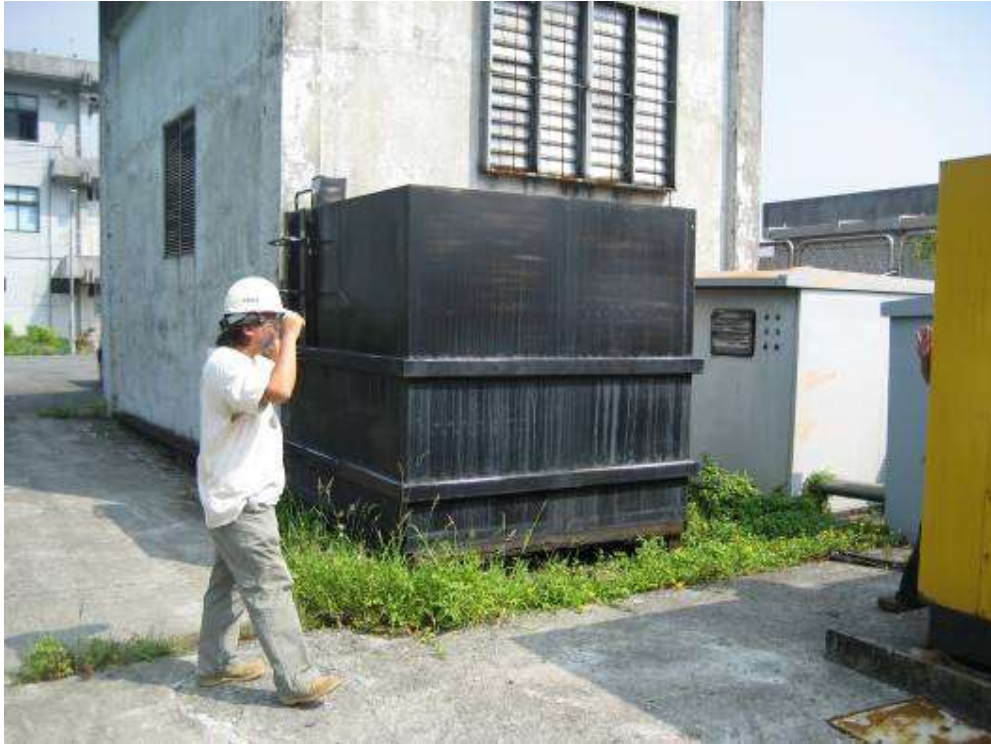
2009/09/01 上午 09:24 貢寮、雙溪營運所(施工前紀錄片)
