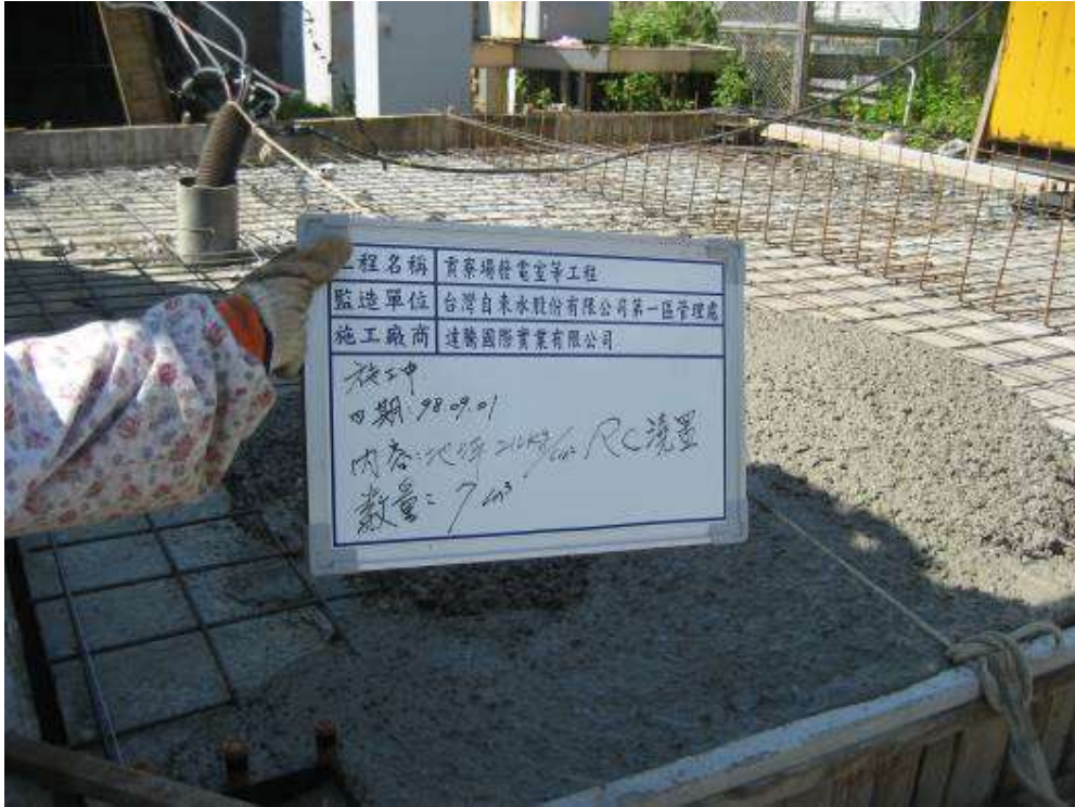
2009/09/01 下午 14:20 貢寮、雙溪營運所(地坪 210Kg/cm 2 RC 澆置 數量:7m 3 )(施工中紀錄片)
