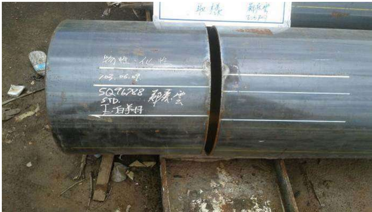
施工前 103.6.9 -24" A53 B PIPE 會同取樣
