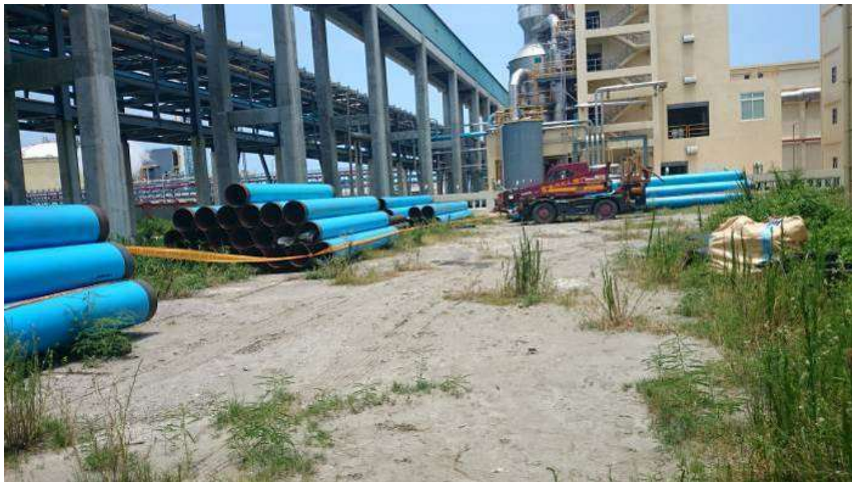
103.6.20 全案管料-進場完成並圍安全警示帶
