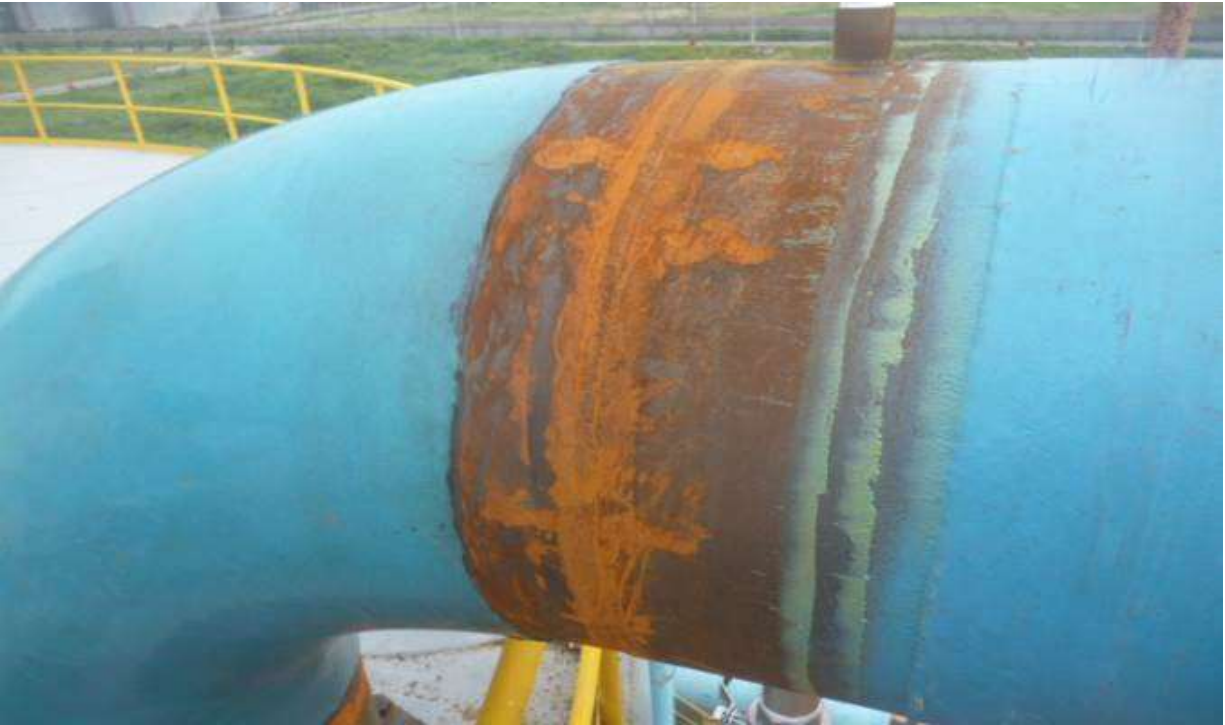
103.8.16 施工前-接合點PE防蝕纏繞包覆
