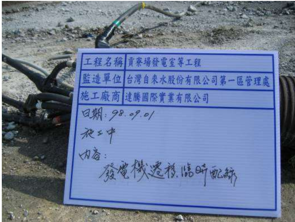
2009/09/01 上午 09:55 貢寮、雙溪營運所(發電機遷移臨時配線)(施工中紀錄片)
