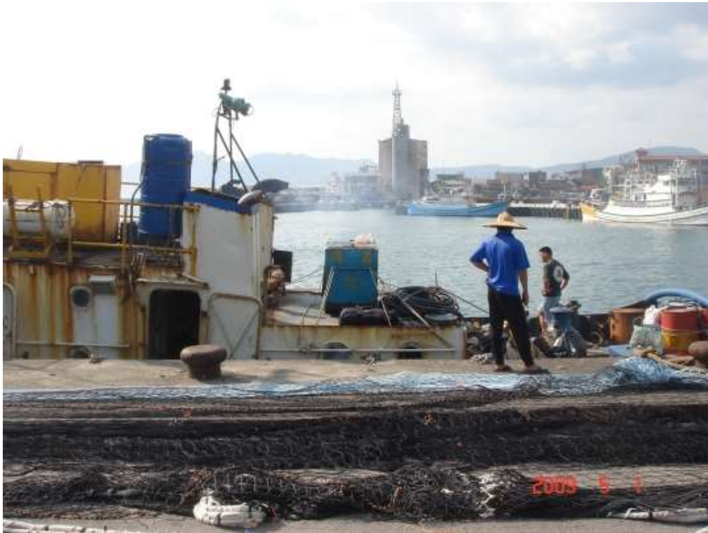
98年核四出水口盲蓋水下切割前充水作業
