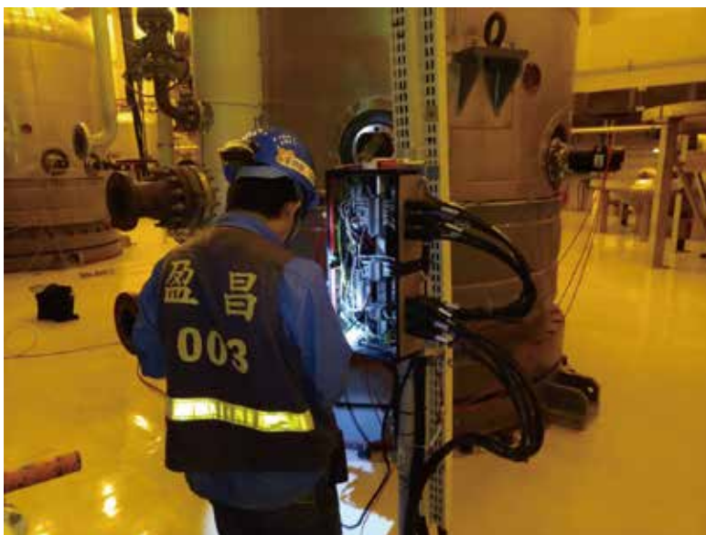
◀ 現場實際施工相片
