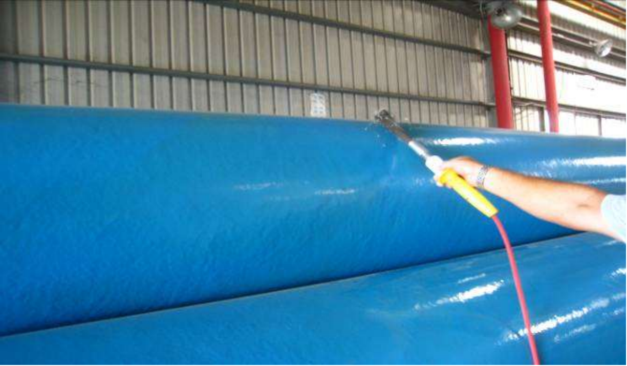
103.6.16 24" 管 PE 包覆 12000V 針孔測試
