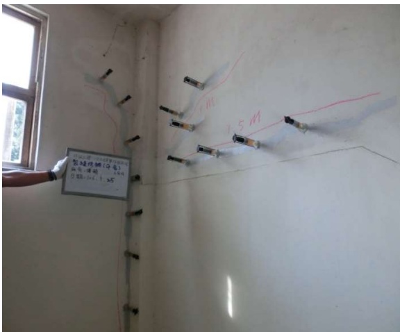
裂縫灌注補強
