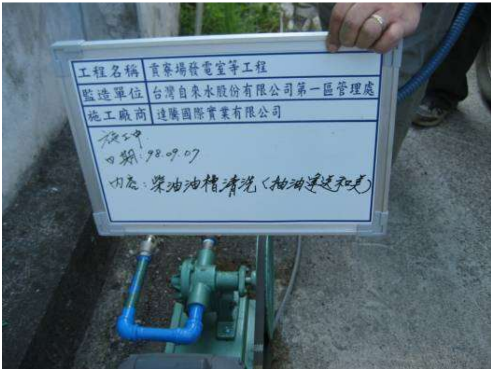
2009/09/07 上午 08:52 貢寮、雙溪營運所(柴油油槽清洗-抽油搬運至和美加壓站)(施工中紀錄片)
