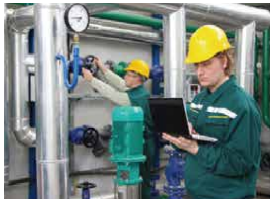
儀器歲修工程
