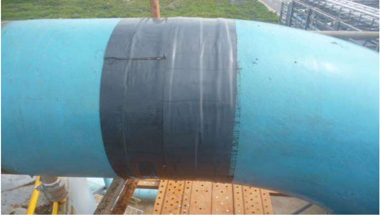
103.8.16 施工後-接合點PE防蝕纏繞包覆
