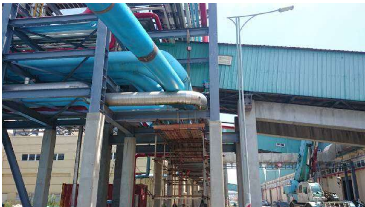
103.7.19 施工中-600A PIPE STD 9.5t 141kg/M BWE 吊裝
