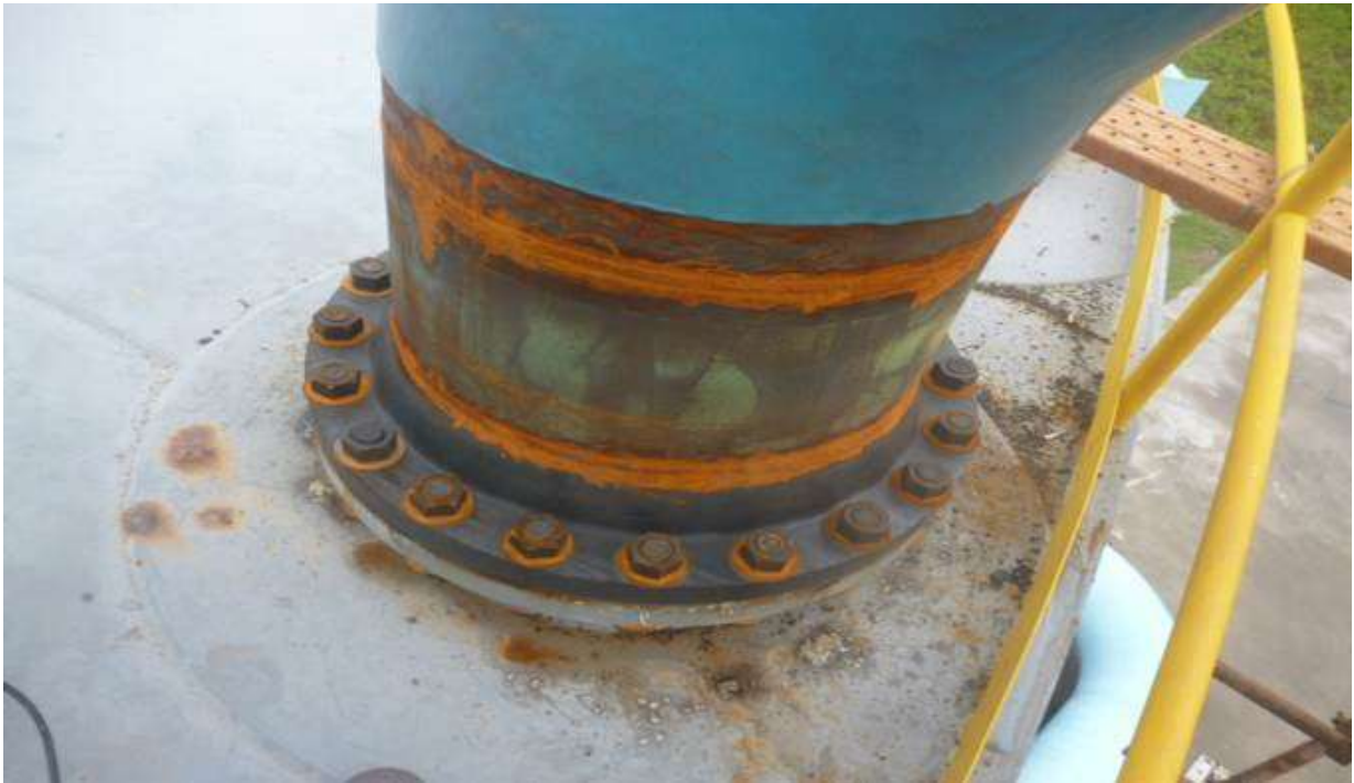
103.8.16 施工前-接合點PE防蝕纏繞包覆
