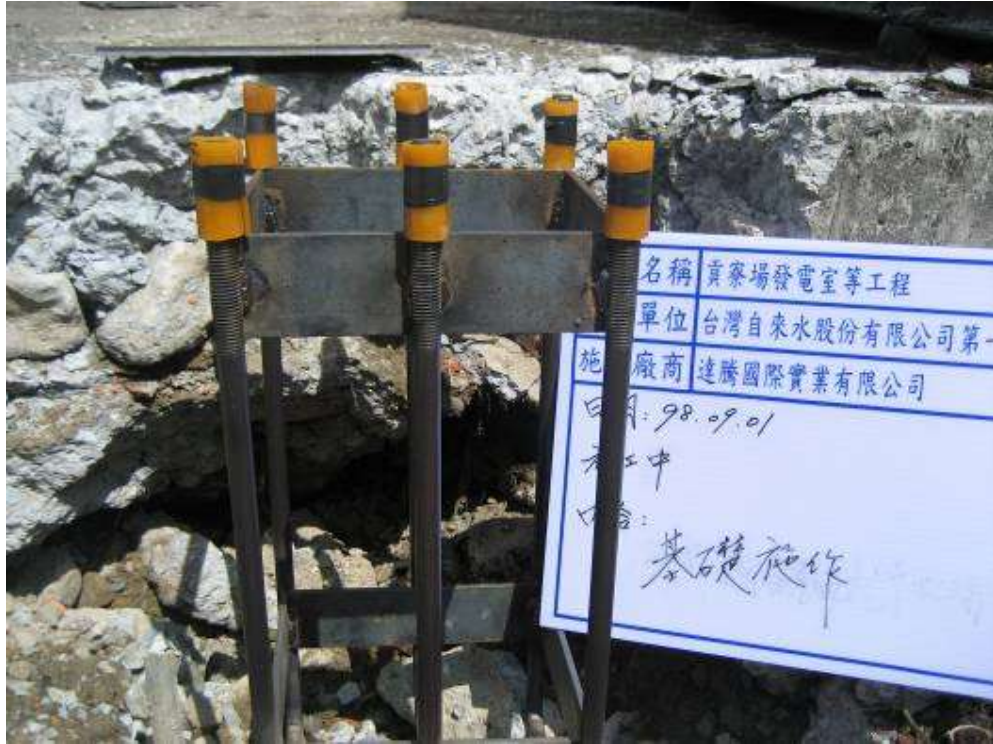
2009/09/01 上午 10:35 貢寮、雙溪營運所(發電機室基礎施作)(施工中紀錄片)
