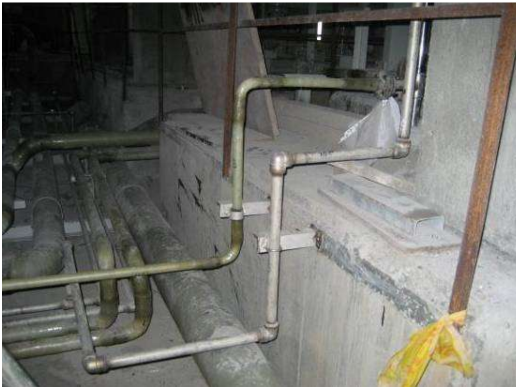
2008年7月13日 ECB 現場管溝 Piping&Support 紀錄相片
