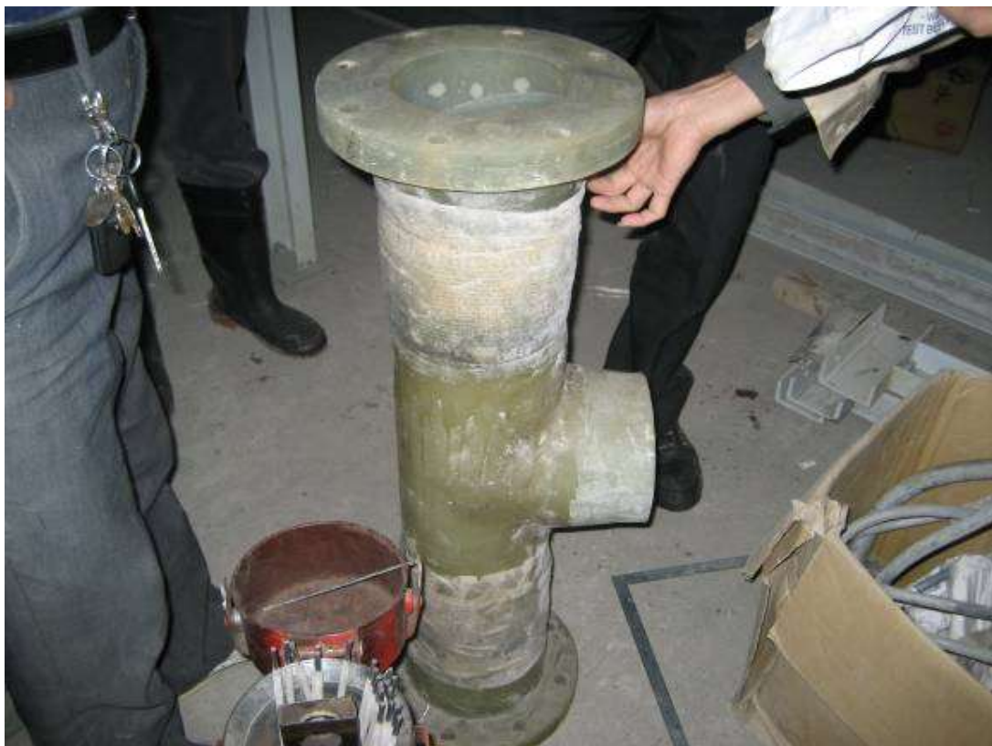
2008年1月23日 ECB Y54系統廠家派員會勘FRP Fitting紀錄相片
