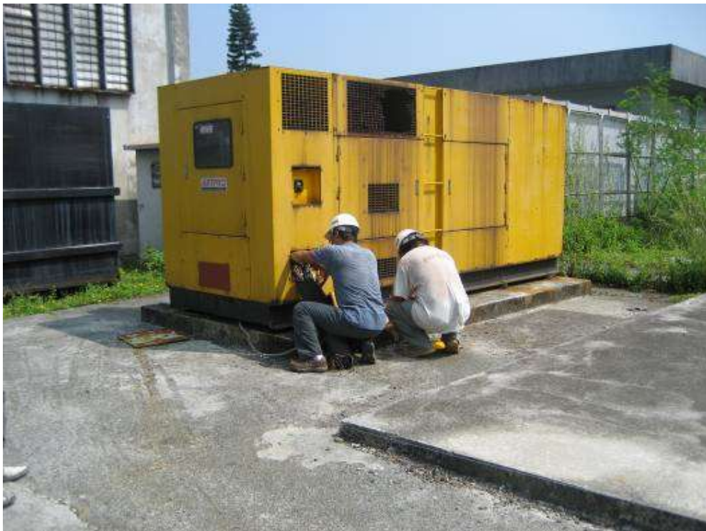
2009/09/01 上午 09:24 貢寮、雙溪營運所(拆除發電機動力線,以便暫時遷移)(施工中紀錄片)
