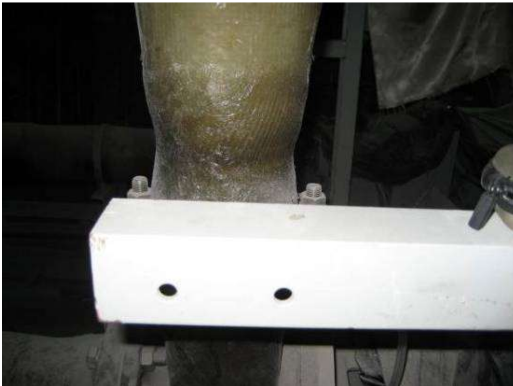
2008年7月11日 ECB FRP Piping 包覆完成面
