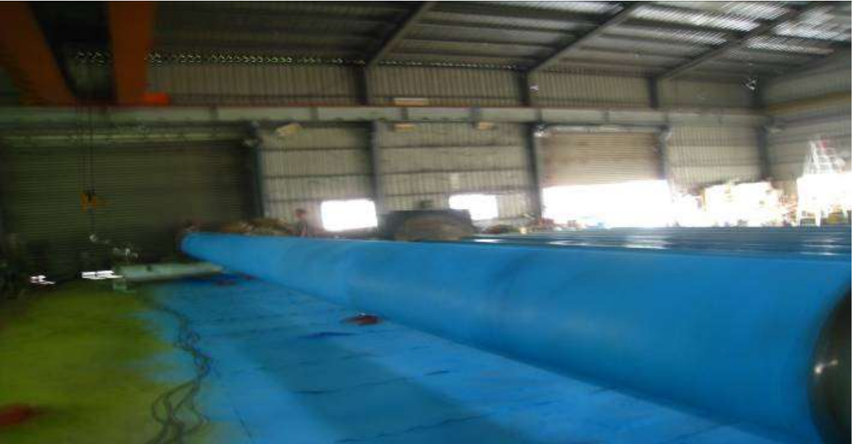
施工中 103.6.14 - 24" 管 PE 包覆
