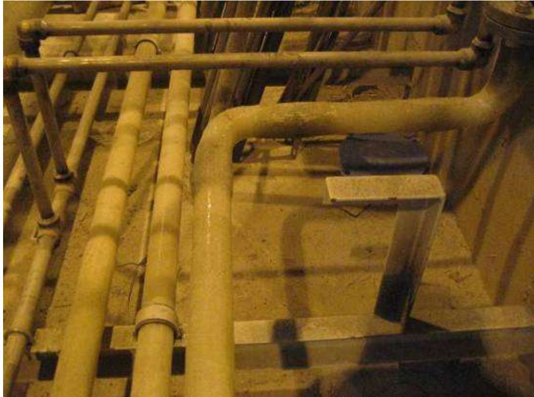
2008年7月18日 ECB Piping 現場施作紀錄相片
