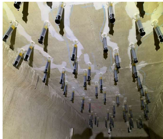
裂縫灌注補強
