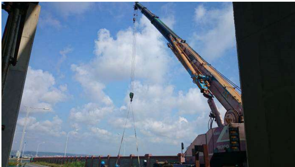
103.7.18 施工中-600A PIPE STD 9.5t 141kg/M BWE 吊裝
