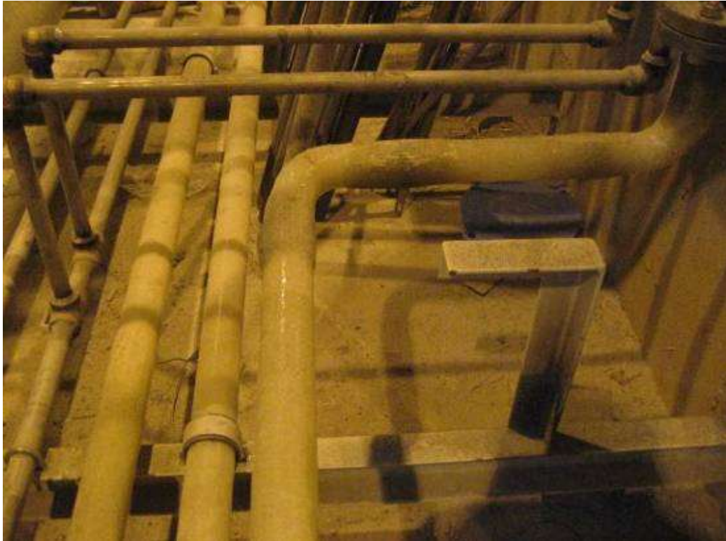
2008年7月18日 ECB Piping 現場施作紀錄相片
