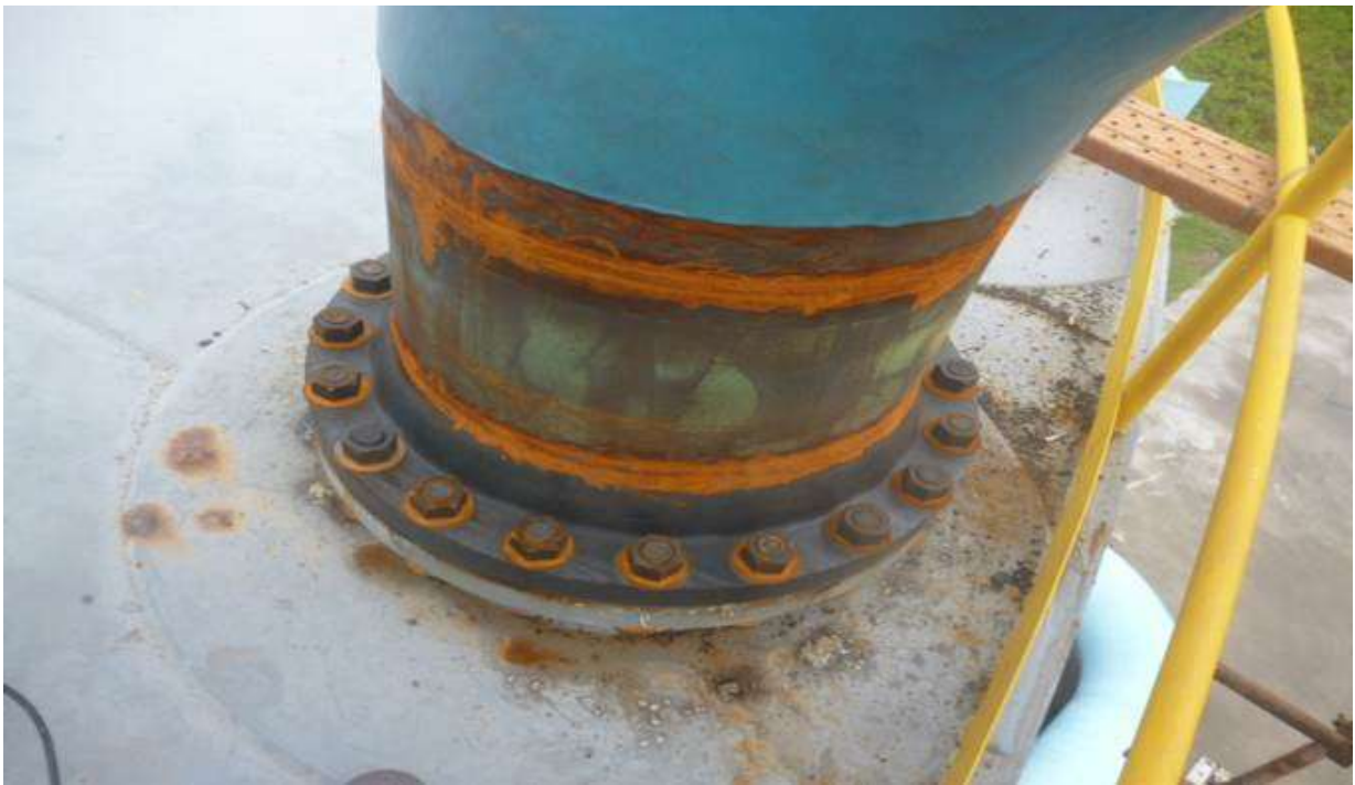
103.8.16 施工前-接合點PE防蝕纏繞包覆
