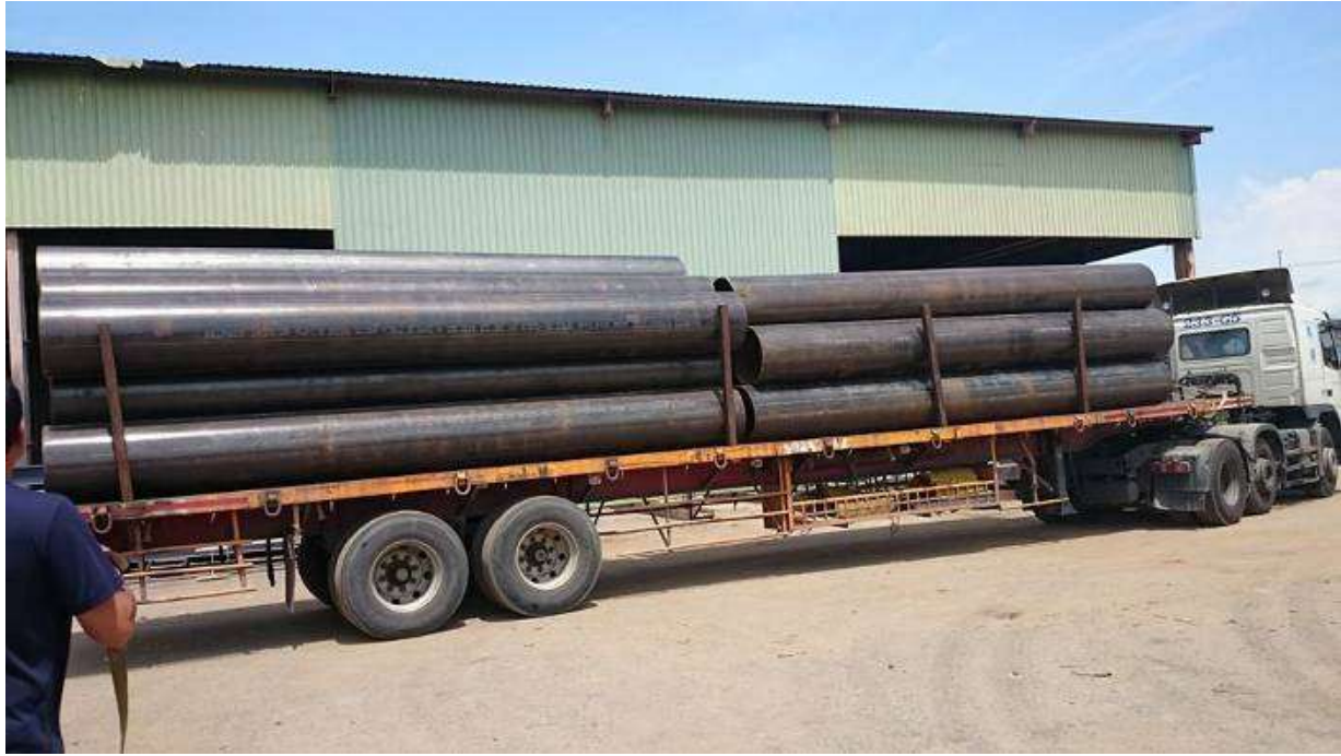
施工前 103.5.26 批號 SIN2211030 24" A53 B 6M/支 PIPE 噴砂廠噴砂準備
