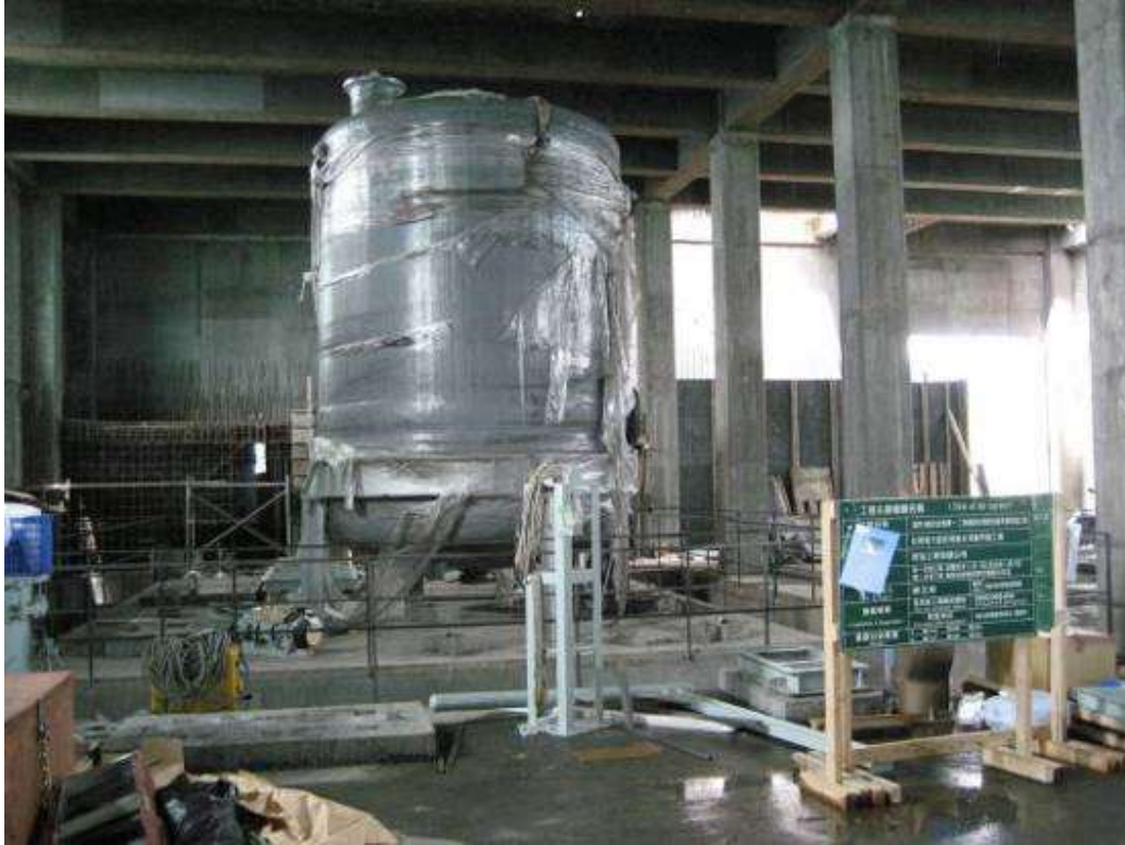
2007年5月22日 ECB 1Y54-TNK-5004 安裝現況相片
