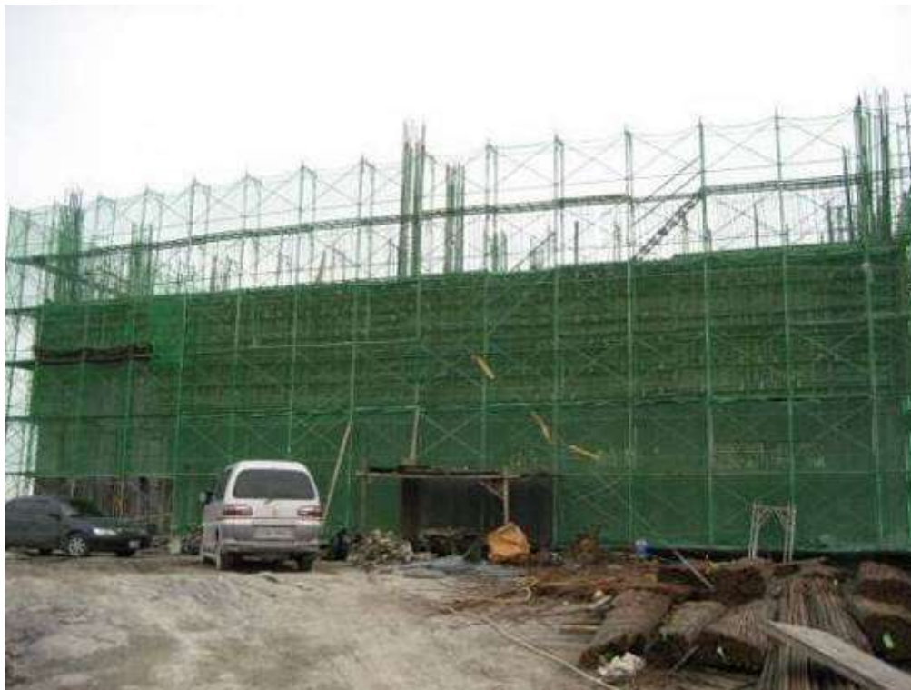
2007年2月14日 ECB主結構外觀現況相片
