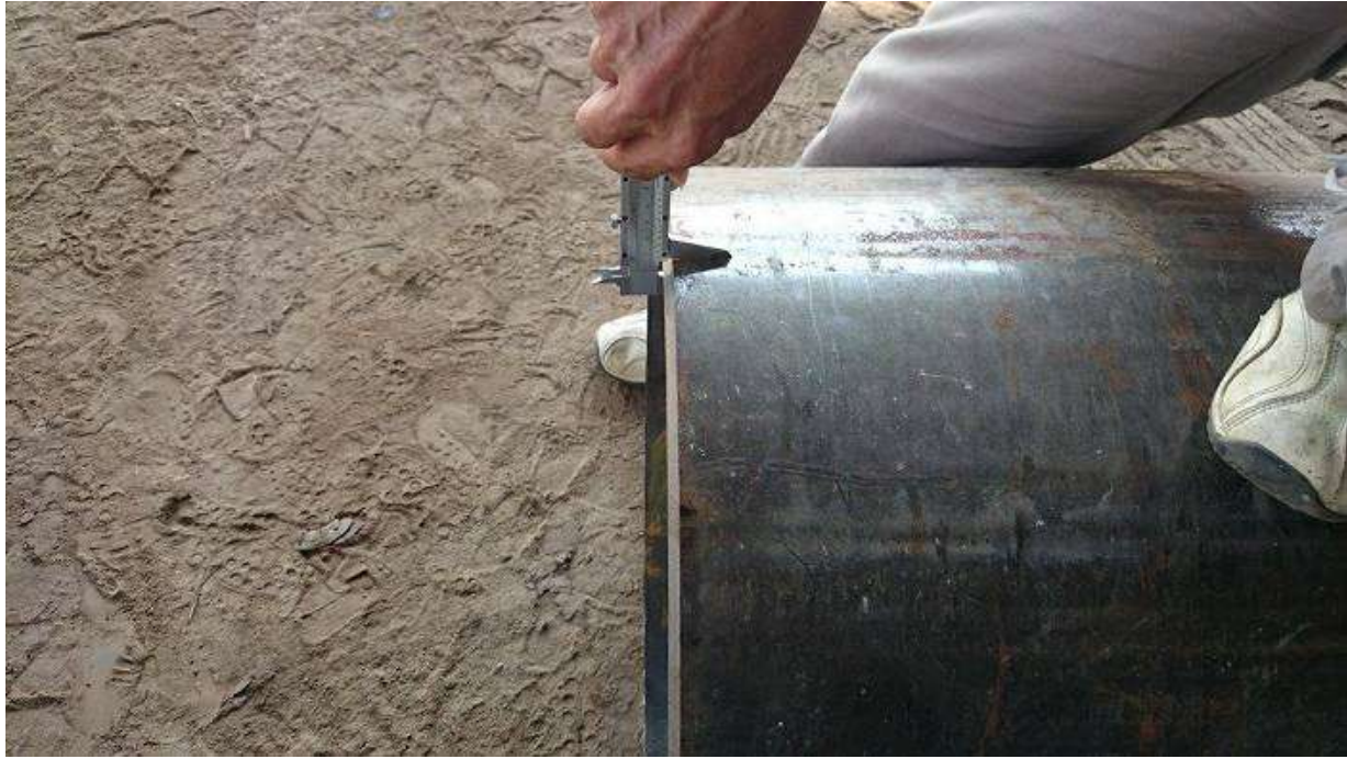
施工前 103.5.27 24" A53 B PIPE 厚度自主檢查
