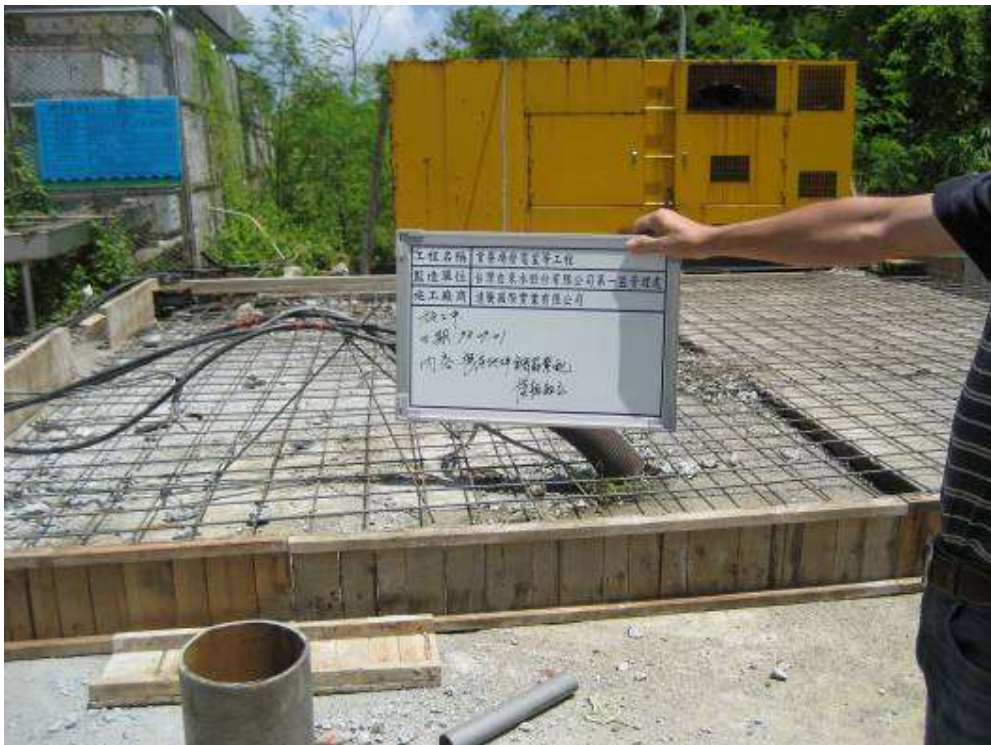
2009/09/01 上午 10:55 貢寮、雙溪營運所(發電機室地坪鋼筋紮配、模板組立)(施工中紀錄片)
