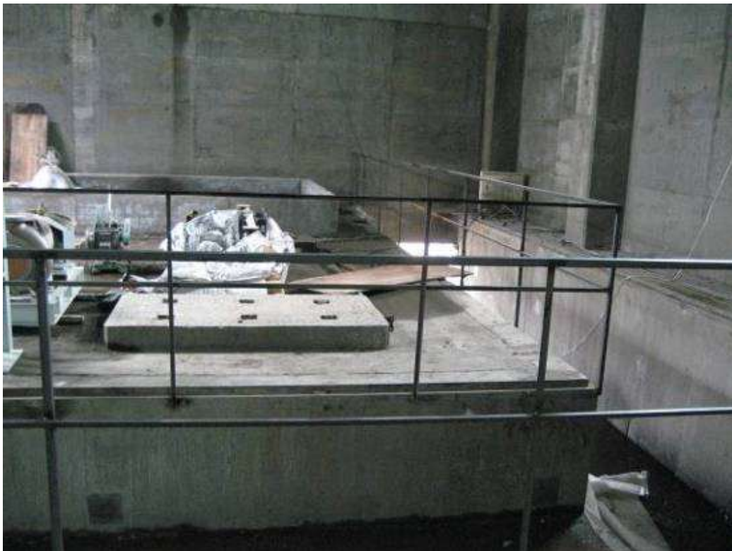
2007年5月22日 ECB 2Y54-P-5001 Foundation 現況相片
