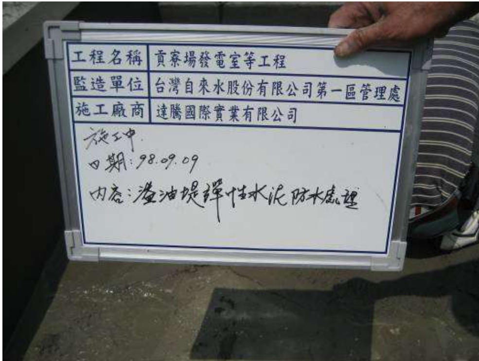
2009/09/09 上午 11:18 貢寮、雙溪營運所(溢油堤彈性水泥防水處理)(施工中紀錄片)
