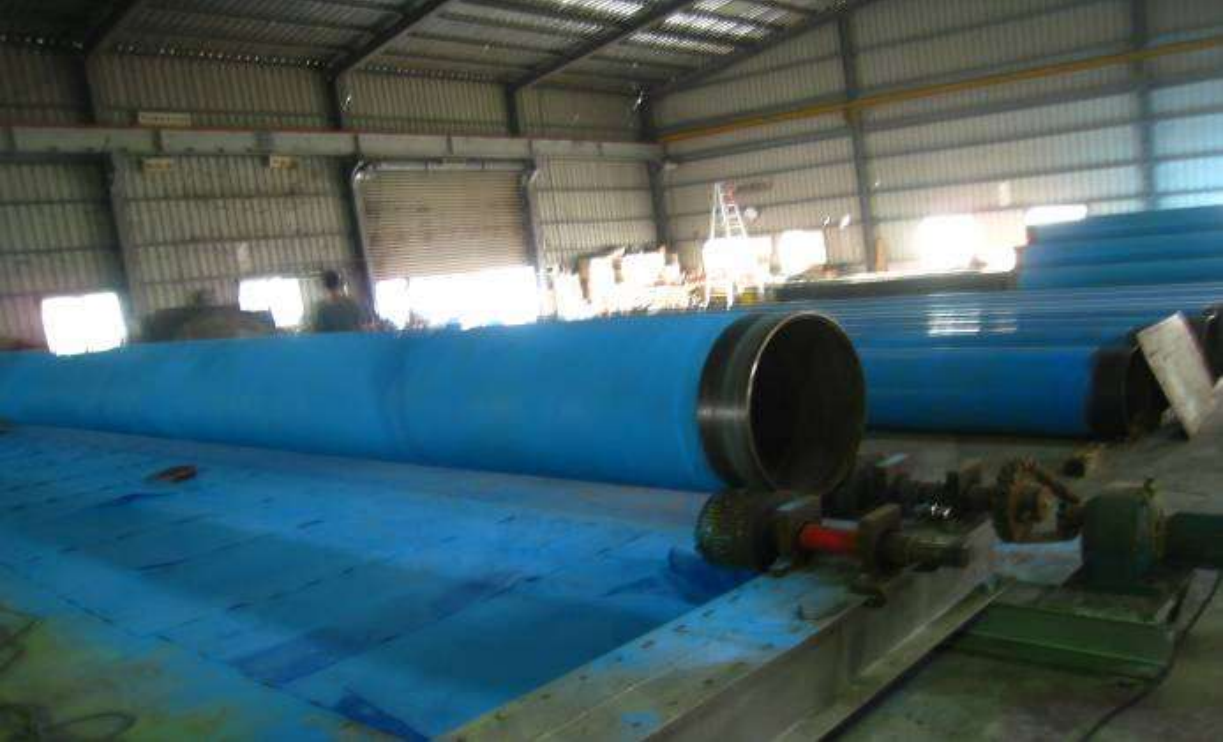
施工中 103.6.14 - 24" 管 PE 包覆
