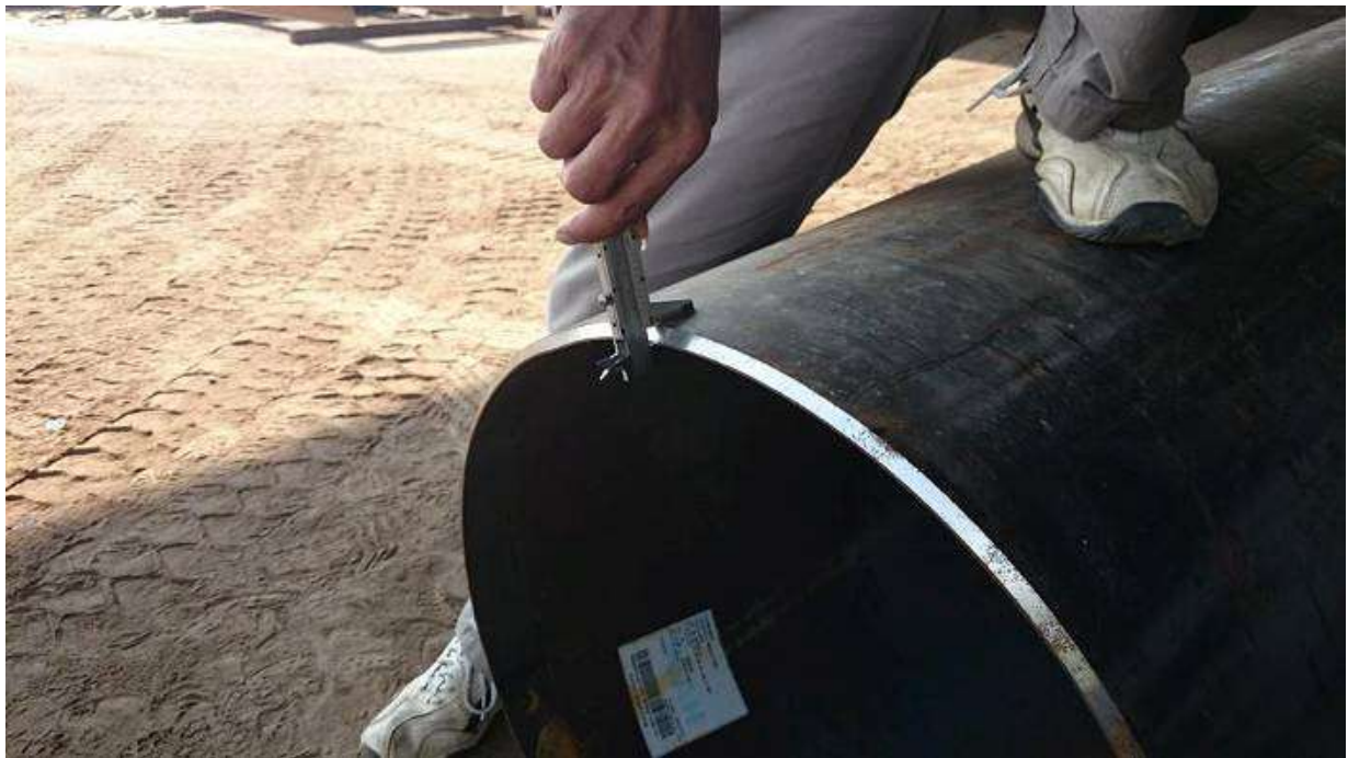
施工前 103.5.27 24" A53 B PIPE 厚度自主檢查
