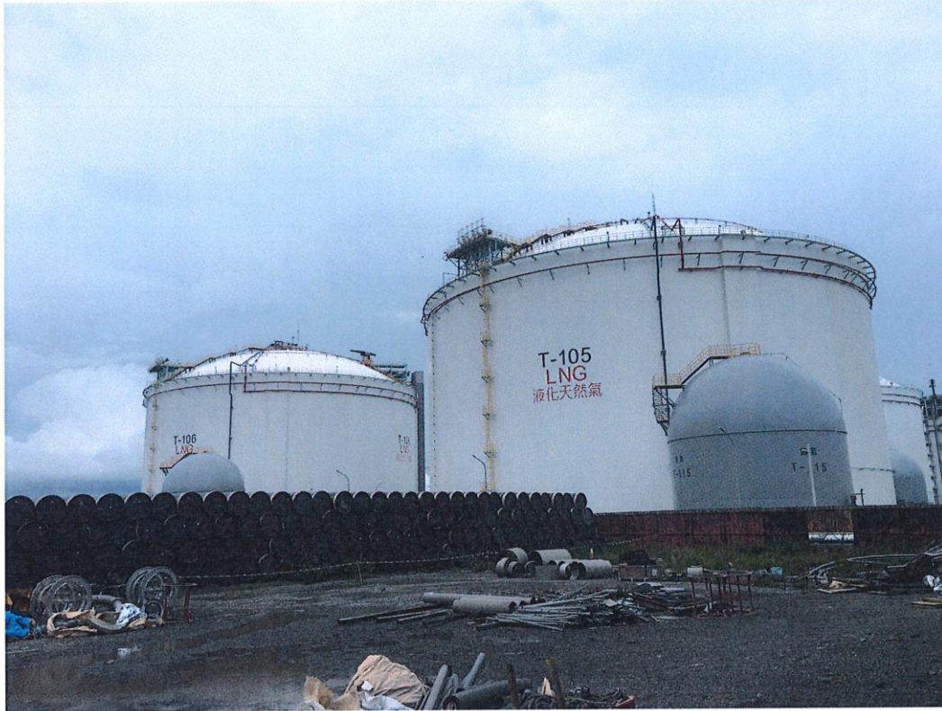
台中港 16 萬噸低溫儲槽建造 3 座
